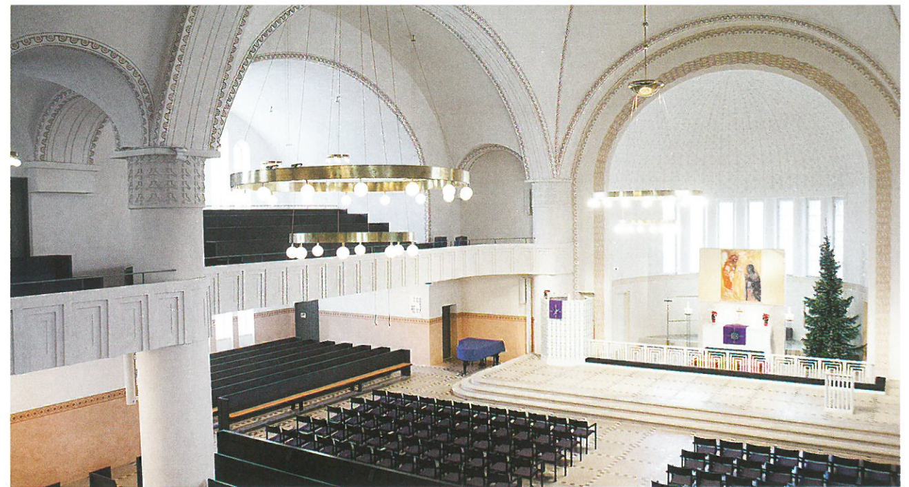
Suure töö uhke tulemus ehk vaade saali: kirikut poolitanud vahesein on lammutatud, seinad krohvitud, ehitatud rõdud, paigaldatud uus põrand, lisatud tehnosüsteemid, renoveeritud aknad-uksed.
